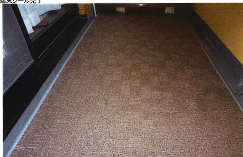
長尺シート貼及び端末シール完了
