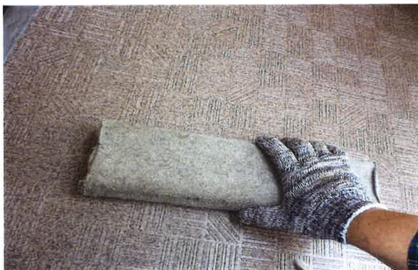
長尺シート貼及び端末シール完了
