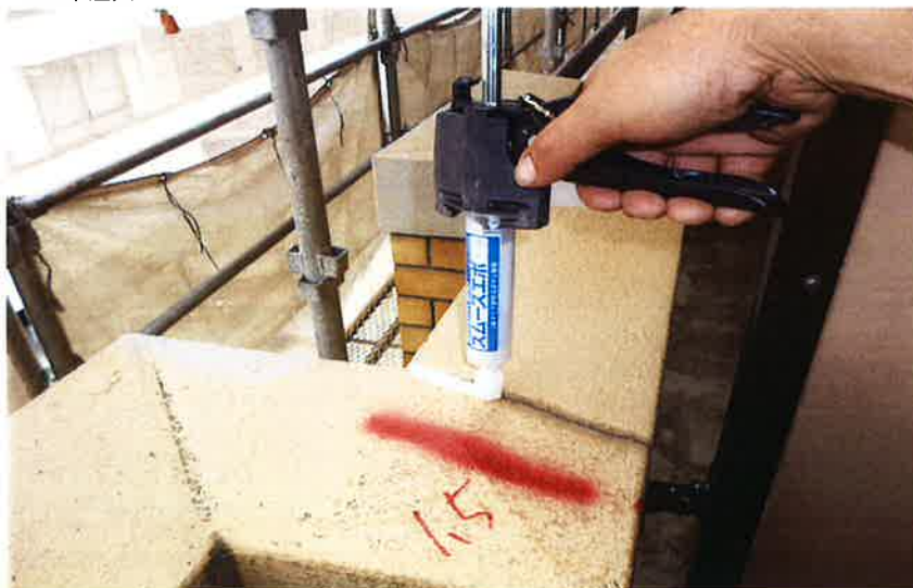
ひび割れ補修スモースエポ注入
