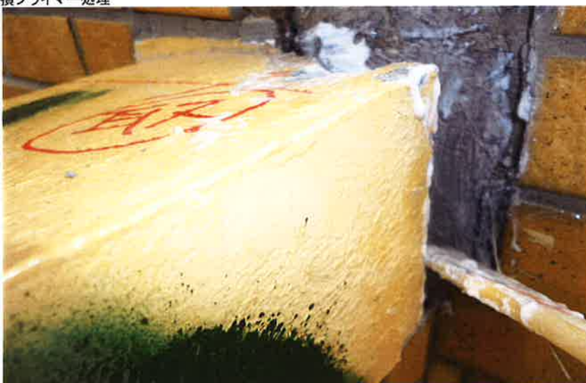
廊下手すり天端欠損プライマー処理
